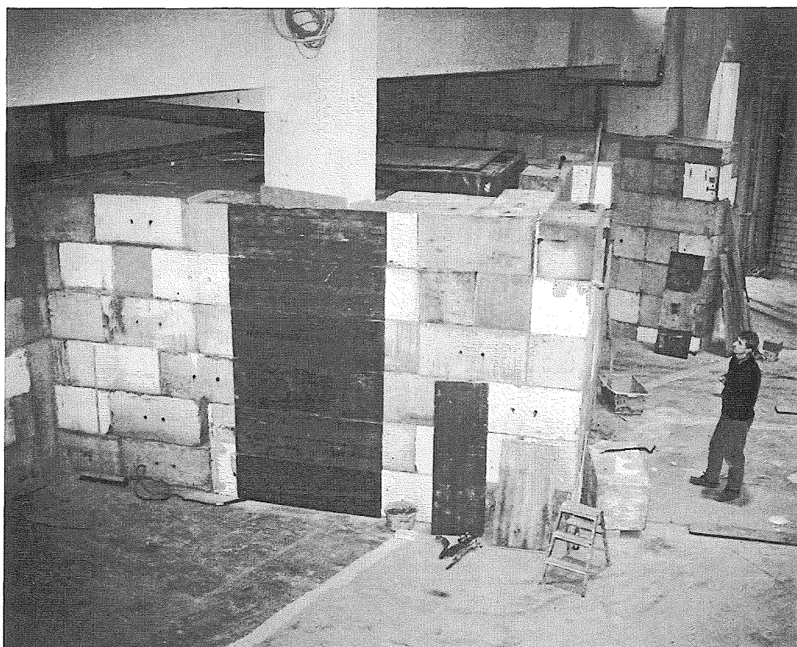
Abb. 6-11 : TOF Beamstop im Aufbau (gemäß Abb. 6-6), Seitenansicht.
