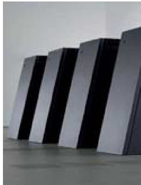
JUBL. In seinen vier klimatisierten Türmen arbeiten insgesamt 16 384 Prozessoren.
