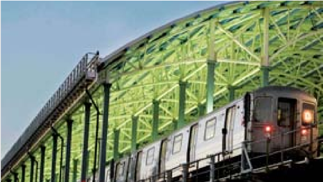
New York, Dachkonstruktion der Stillwell Avenue Terminal, größte gebäudeintegrierte Dünnschicht-Photovoltaikanlage der Welt.
