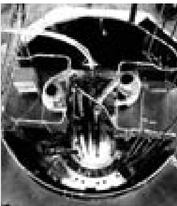
Ein faszinierender Anblick: die hellblau leuchtende Cherenkov-Strahlung im offenen Tank des Forschungsreaktors MERLIN.
