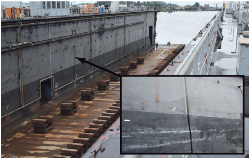
Abbildung 15: Applikation unter Werftbedingungen im Schwimmdock in Emden
