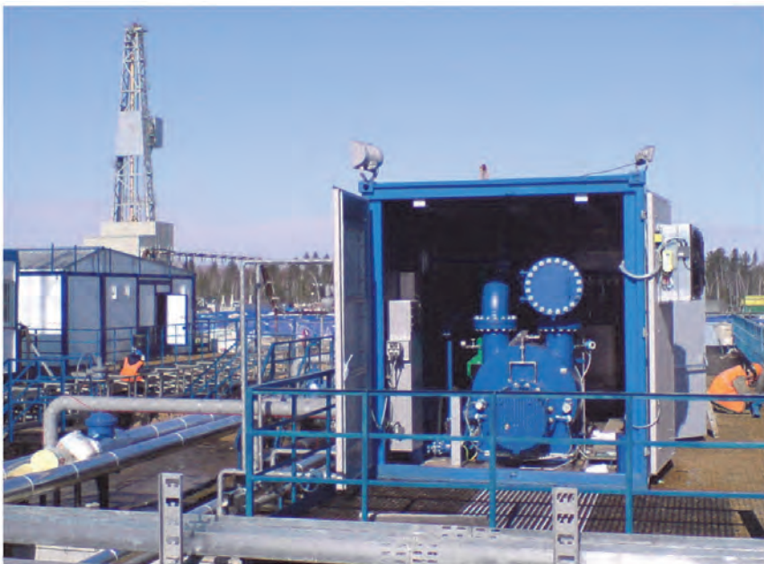
Abbildung 13: MP-System für schwer zugängliche Gebiete des russischen Partners (3x Baugröße MPC268, wie Versuchsanlage Rütenbrock, Entwicklungsstand integriert)
