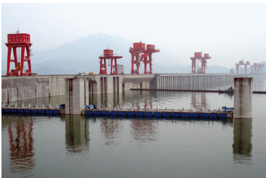
Abb. 3: Die Staumauer des Yangtze (wasserseitig)
