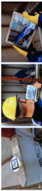
Abbildung 10: Anwendung der AR-gestützten Arbeitsunterlage: (a) Marker zur Orientierung; (b) Soll-Ist-Abgleich mit AR; (c) Detailsicht des Tablets
