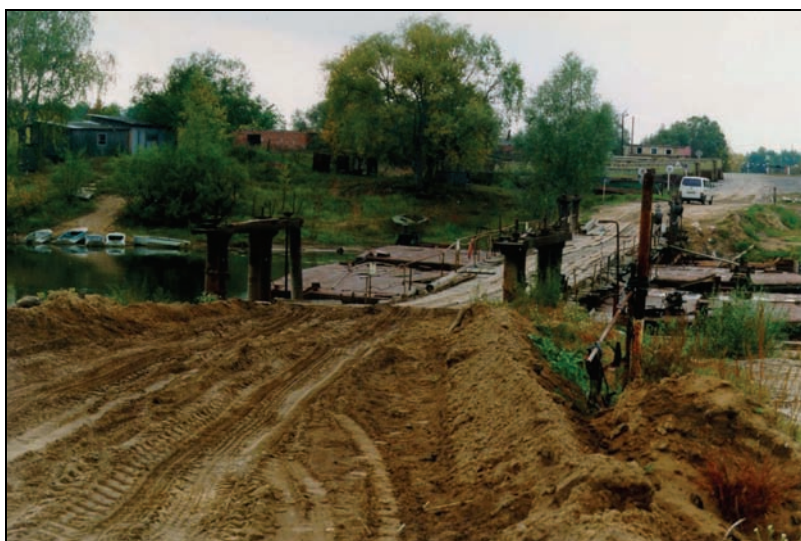
Foto 6: Die alte Pontonbrücke über die Sosch (vor 2003)
