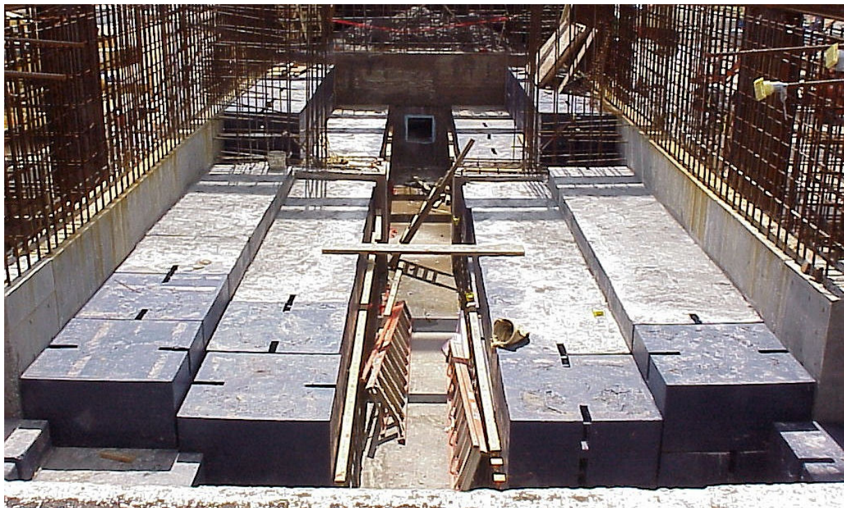
Abb. 5.3-13: Aufbau der Protonenstrahlführung der Spallationsquelle SNS
