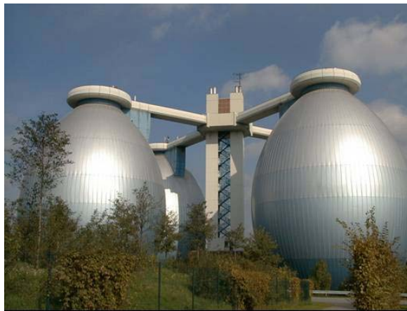
Abbildung 3: Faulbehälter der Kläranlage Bottrop
