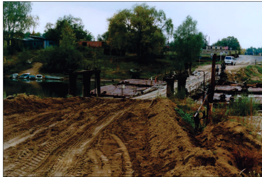
Foto 4 : Die alte Pontonbrücke über die Sosch (vor 2003)
