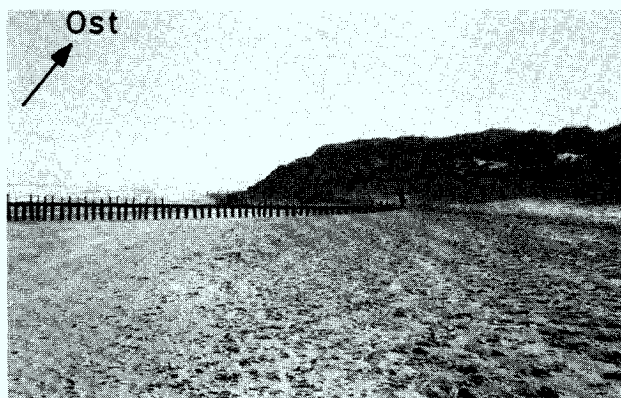
Abb. 12.5: Abtrag der Randdüne bei der letzten Buhne von Norderney im Jahre 1979
