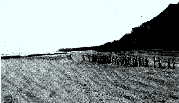
Abb. 12.19: Abtrag der Randdüne ab der letzten Buhne von Nor-derney im Jahre 1983
