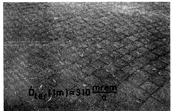
Abb. 7.2: Straße mit Kupferschlackensteinen am Hafen von Horemersiel, Abb. 9
