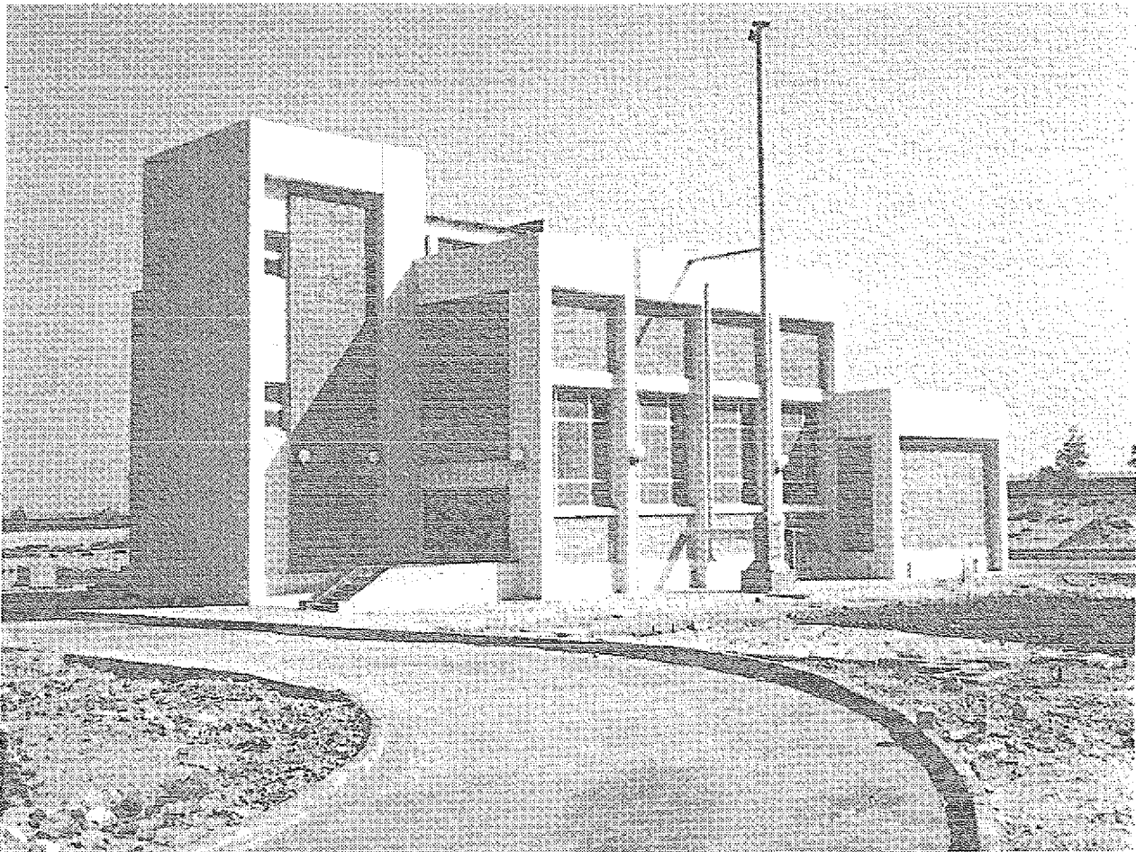
Abb. 8a Gebäudeansichten Südseite mit Montagotor Westseite mit Schornstein
