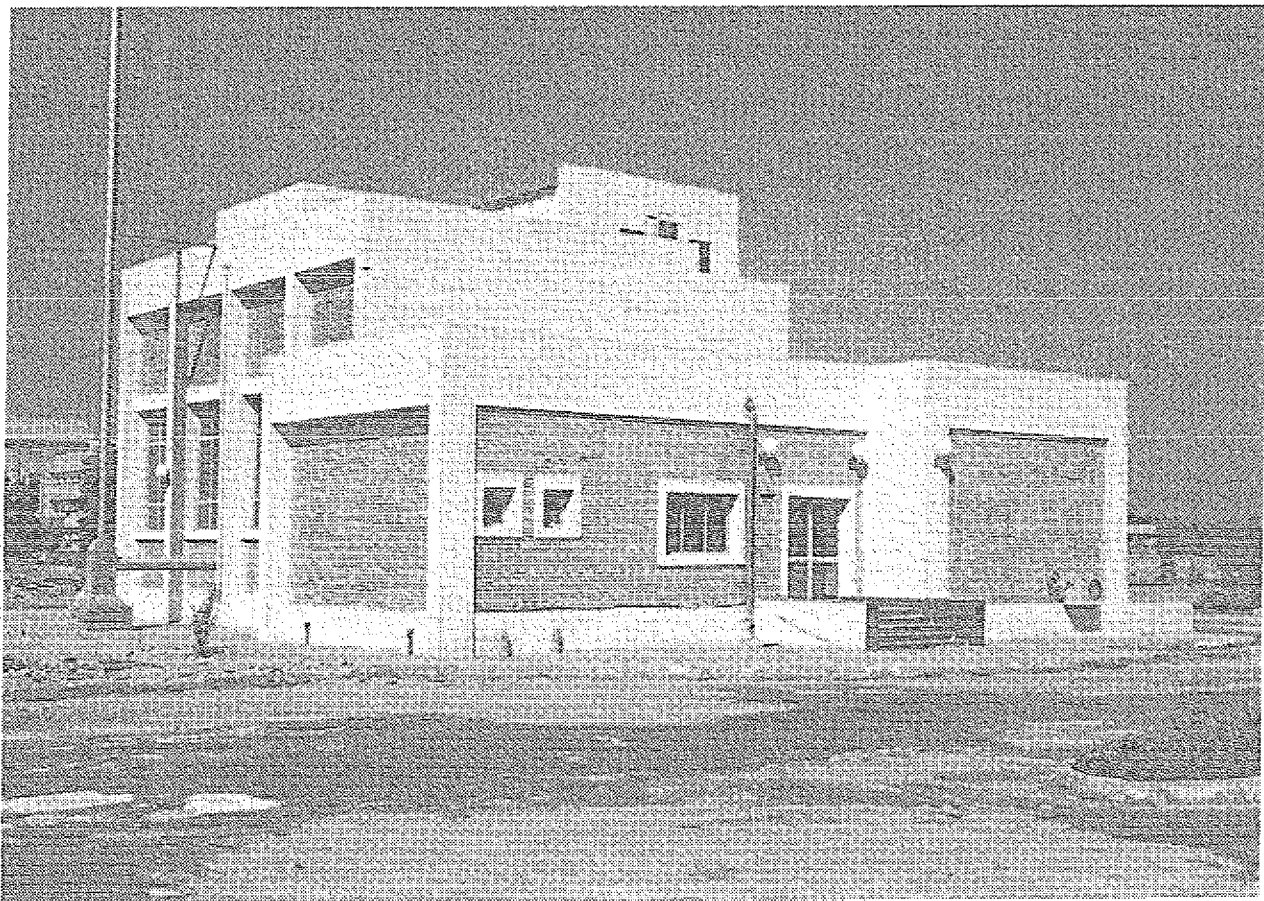
Abb. 8b Gebäudeansichten Nordseite mit Haupteingang
