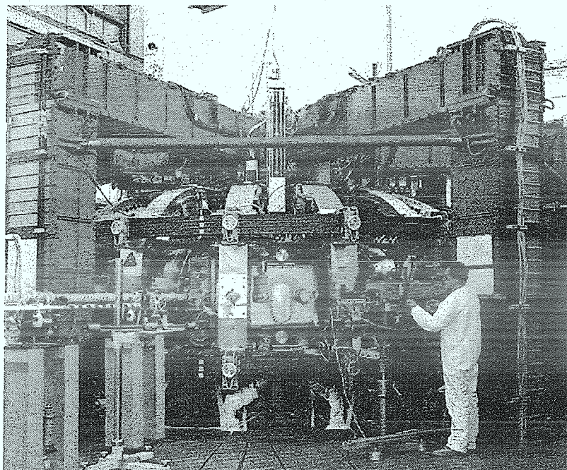
Abbildung 3.8 Blick auf TEXTOR kurz nach der Fertigstellung im Jahr 1982. Vakuumgefäß, Toroidalfeldspulen und Transformatorjoche sind hier noch gut zu sehen. Mittlerweile sind sie von Diagnostiken und Zusatzaggregaten weitestgehend verstellt: aus [163].
